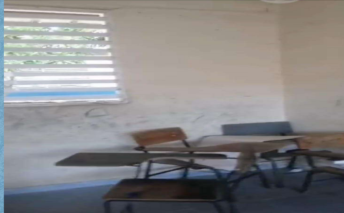
Pintura interior y exterior aulas sede Concentración Escolar
