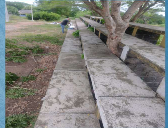
Pintura de las gradas viejas, punto de encuentro de estudiantes para merendar
